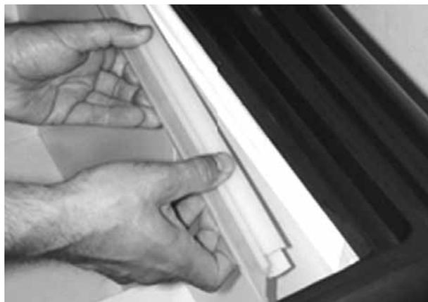
Abb. 6: Leuchtenabdeckung entfernen
